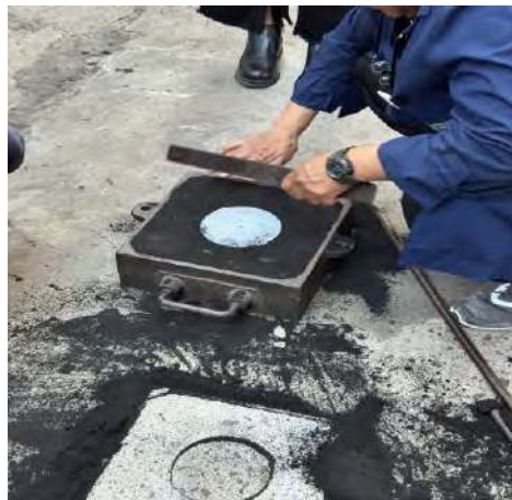
Imagen 11: Nivelación de la superficie
