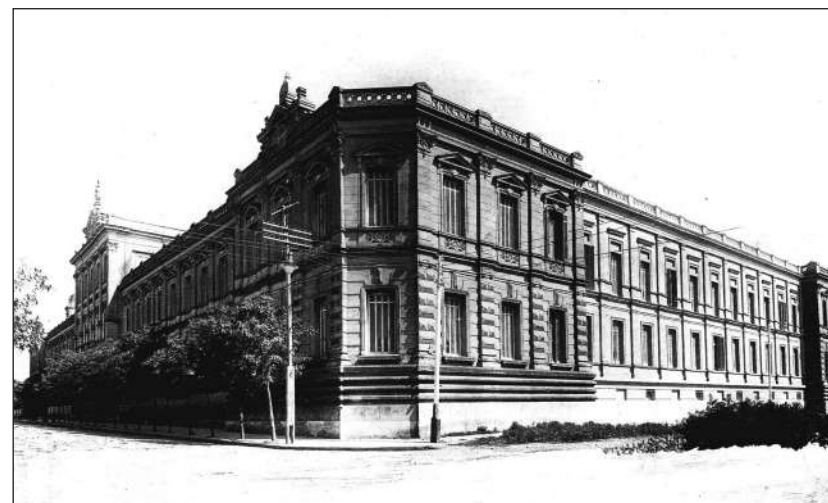
Ilustración N° 14. El edificio del Seminario en la esquina de José Cubas y Concordia, actual entrada a la Facultad de Teología
